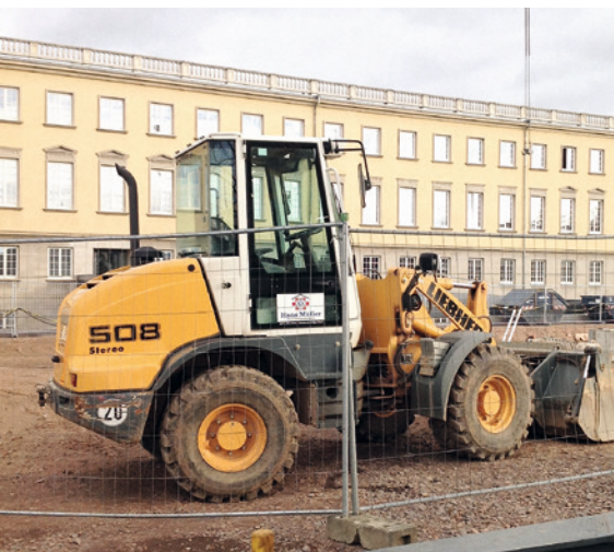
An der Jahnallee wird ein neuer bildungswissenschaftlicher Campus gebaut. (Foto: Annika Schindelarz)
